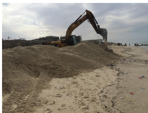
Photo 7 : Travaux de protection (enrochement et muret) à Goxu Mbathie. Sambou D. 01/2019
